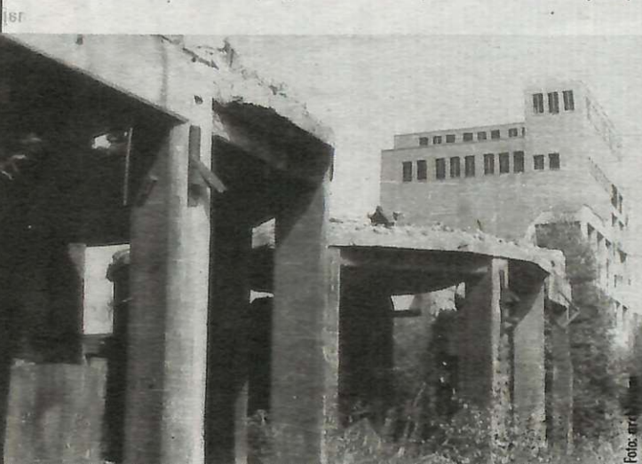
BŁACHOWNIA w 1945 r. Wszystkie instalacje były zniszczone.
