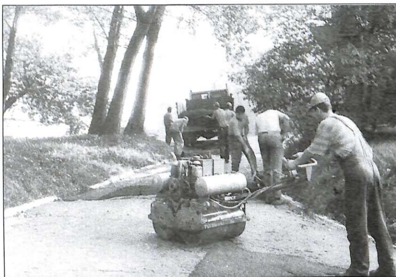
Aura sprzyja drogowcom. Zakładowe szlaki i ulice osiedla poddawane są drobnym naprawom. Najbardziej dokuczliwe wyrwy znikają. Na zdjęciu naprawa nawierzchni drogi prowadzącej do pieca i oczyszczalni
