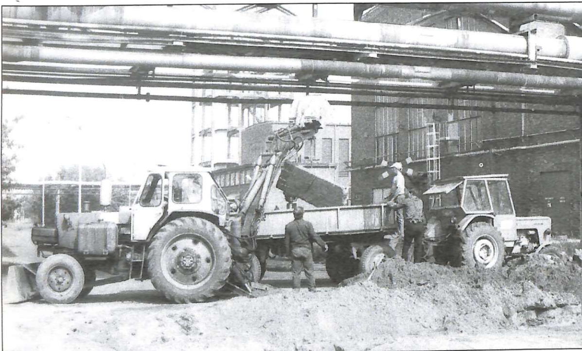
Na skrzyżowaniu ulic 5 i D likwidowano nieszczelności na instalacji wody przemysłowej \varnothing 1200. Wykonywały prace brygady M. Budnego i F. Jasińskiego. Operatorem koparki był J. Dec, traktora J. Ciupka
