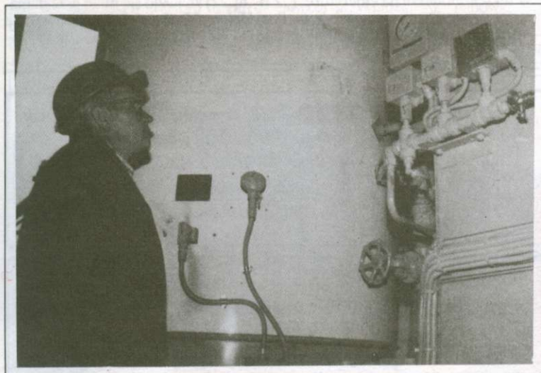
Przy generatorze „Claytona” R. Dudziński.
