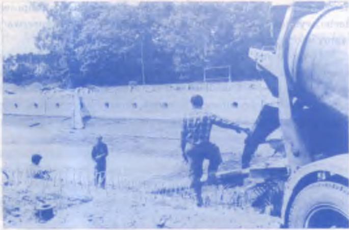
Fot R. Strzelczyk. Remont basenu w Błachowni
