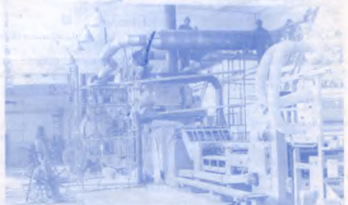
Fot R. Strzelczyk. Montaż linii do produkcji worków wentylowych
