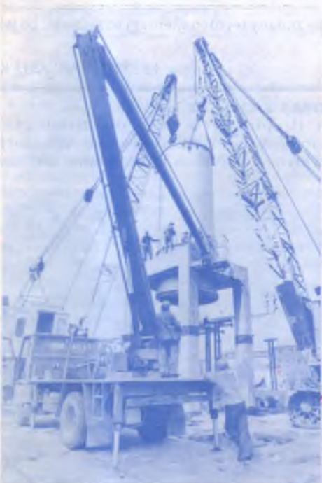
Fot R. Strzelczyk. Montaż zbiornika.
