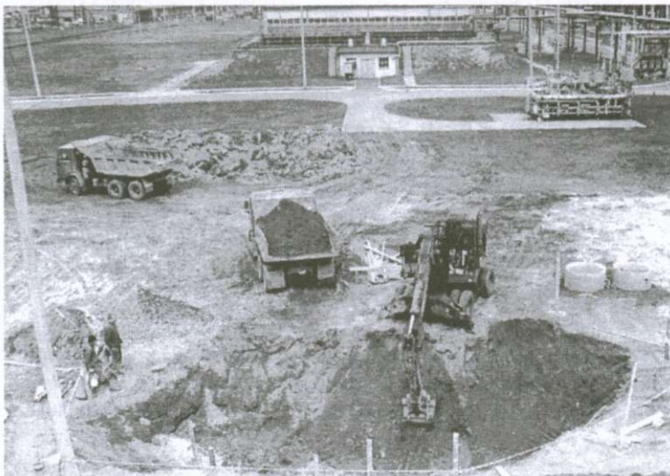
Rozpoczęto wykopy pod fundament stokaża aldehydów
