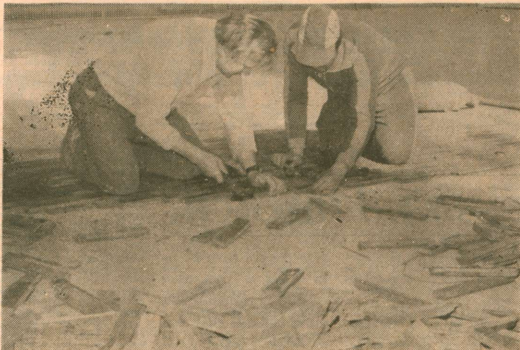
W hali widowiskowo-sportowej wymienia się parkiet. Trwają ostatnie prace wykończeniowe. Oby tylko nasi siatkarze w drugoligowych bojach dostarczyli nam miłych przeżyć. Zdjęcie: B. Rogowski
