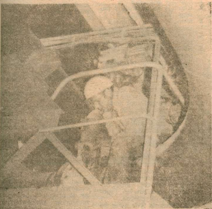
Po podgrzaniu aparatu i zdjęciu warstwy izolacyjnej, ekipy remontowe przystępują do pracy.
