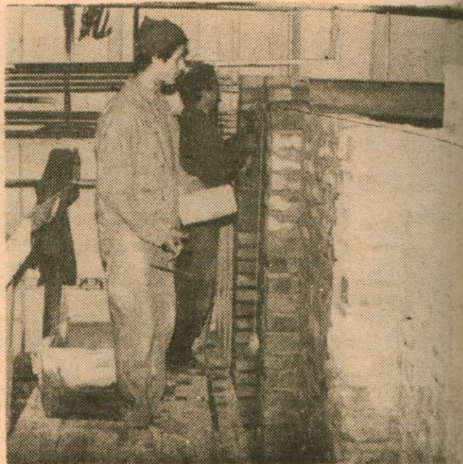
W środku budynku brygady ZWRI stawiają ścianki działowe.
