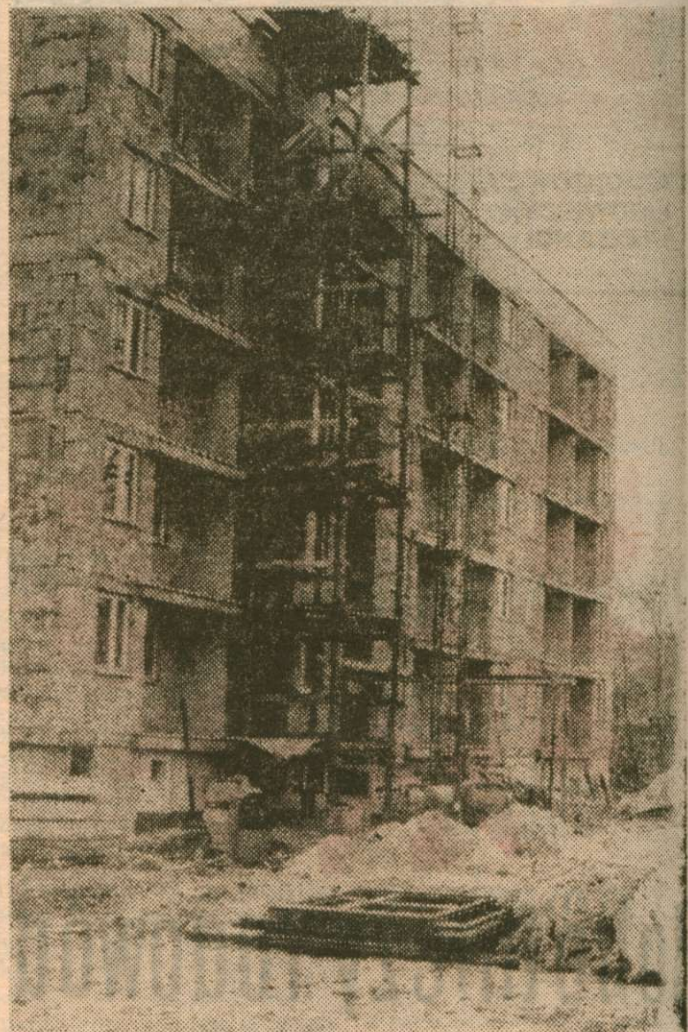
W pierwszym z dwóch budowanych bloków mieszkalnych prowadzone są roboty wykończeniowe.
