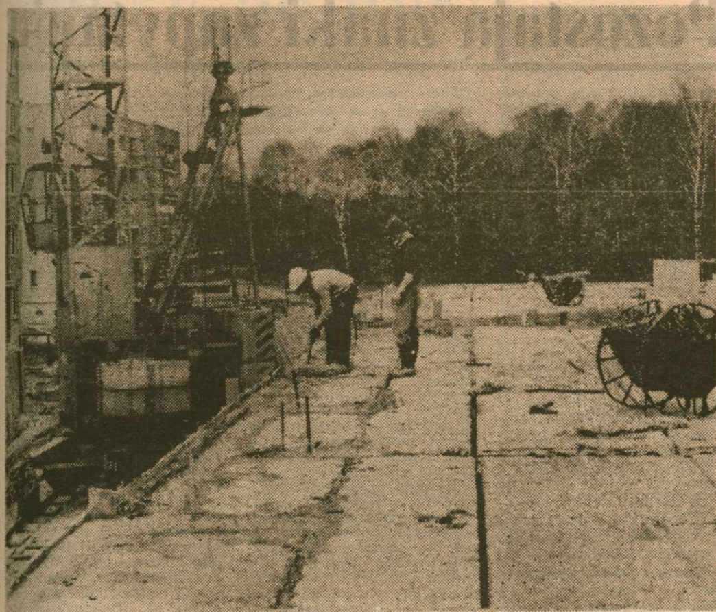
MEJDUNEK Z PLACU BUDOWY — INFORMACJE O WZNOWIENIU DWÓCH KOLEJNYCH „OK”
