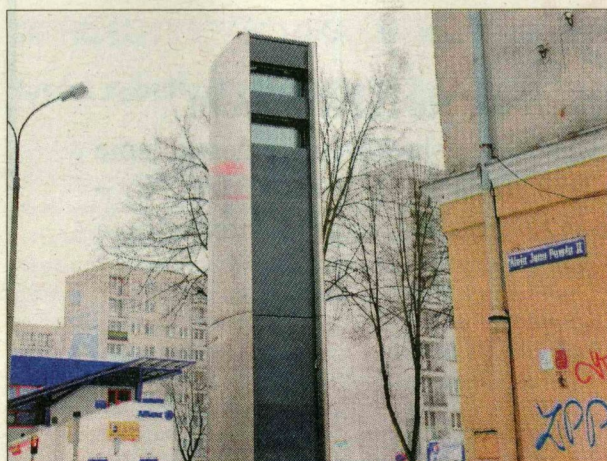
» Uszkodzony maszt na fotoradar znowu jest sprawny.
