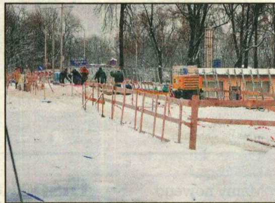
» Prace na moście im. Długosza trwają już kilka miesięcy. To jedyna przeprawa przez Odrę poza mostem na obwodnicy.
