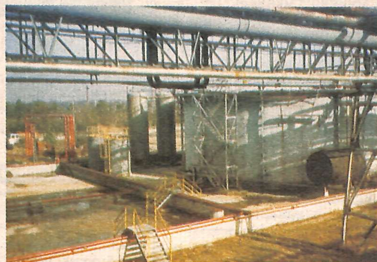
Zbiornik magazynowy ropy naftowej.
