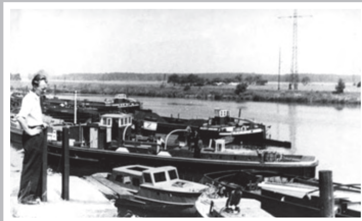
Barki do remontu na Cyplu w Koźlu, 1957 r. Fotografia ze zbiorów Krystyny Balickiej Říční lodě určené k opravě na Poloostrově v Kožli, r. 1957. Fotografie ze sbírky Krystyny Balické
