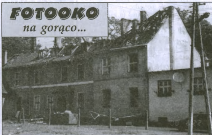
Budynek przy ul. Sławięcickiej zniszczony przez pożar 12 czerwca 2000 roku.
