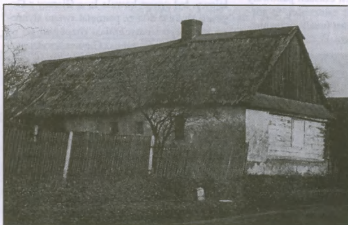
Dom Juliusza Giemsy w Lenartowicach, przy ulicy Powstańców Śląskich 15. Zdjęcie z 1968 roku.
