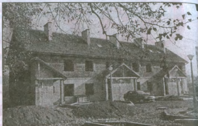
Tak wygląda dom budowany w Gliwicach przez Habitat for Humanity
