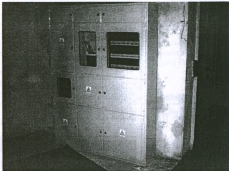
Nowa rozdzielnia elektryczna w zakrystii przed zamontowaniem
