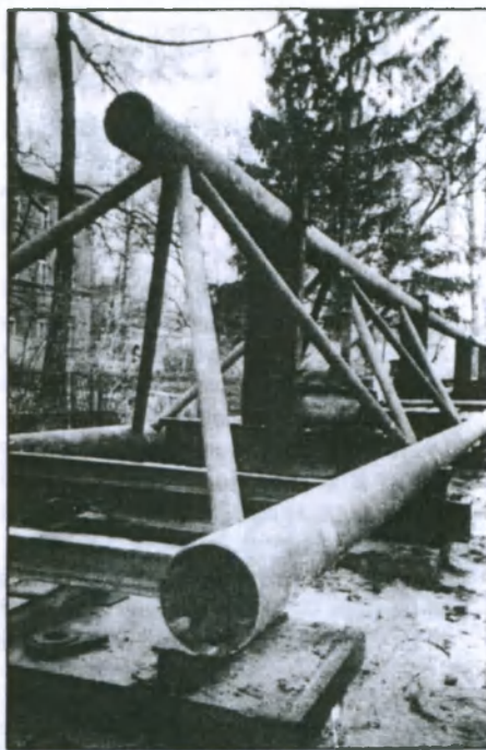
Konstrukcja nowego mostu na rzece Kłodnicy wygląda imponująco
