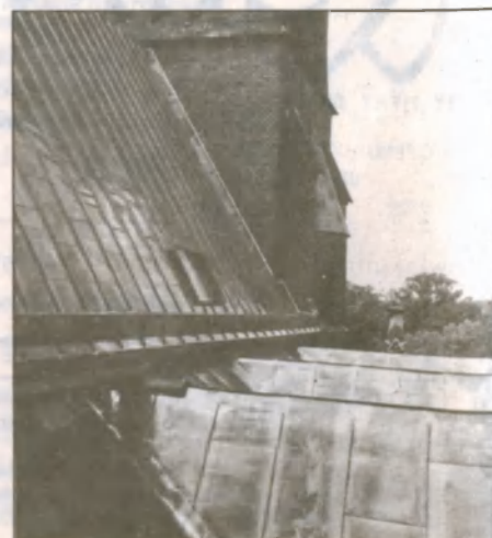
Pięknie błyszczy nasz nowy dach!
