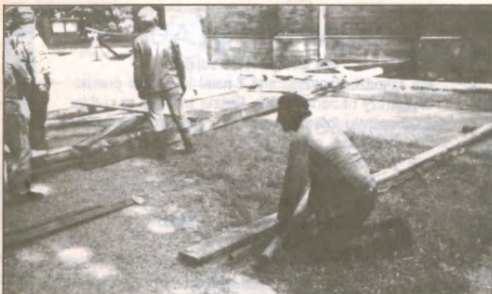
Prace montażowe na dole. Pan Piotr Olcz na pierwszej linii – jak zawsze
