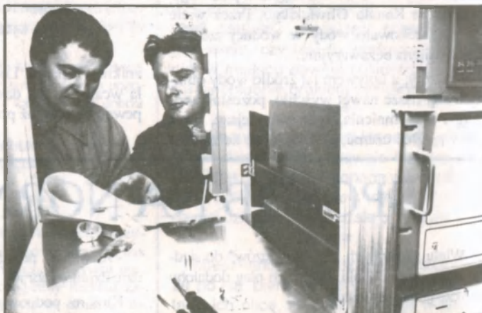
Specjaliści z Kędzierzyńskich Azotów montują urządzenia w stacji pomiarowej BASKI w Sławiećicach.
