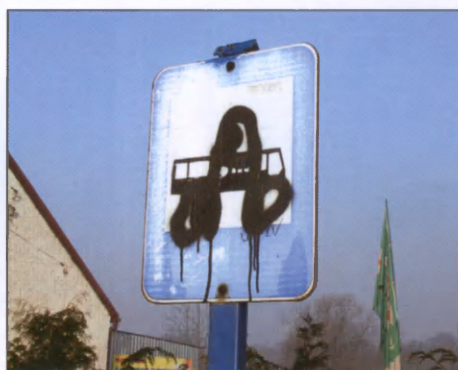
Zniszczony znak przystanku autobusowego
