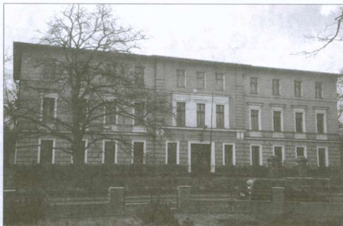
Co dalej z tym pięknym budynkiem?
