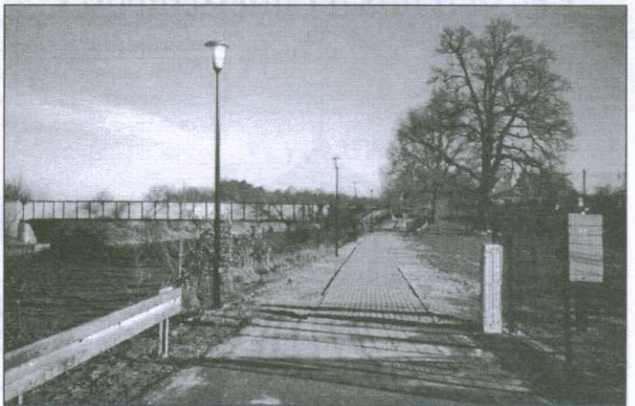
Wypiękniła nam ostatnio ulica Roberta Kocha. Wybudowano nowy chodnik i założono oświetlenie.
