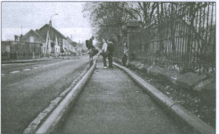
Budowa kanalizacji sanitarnej przekroczyła magiczną linię Kanału Gliwickiego. Na zdjęciu plastikowe rury obok internatu na ul. Sławięcickiej.
