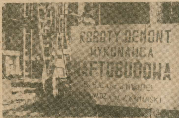
Ten fragment zakładu od kilku lat wyłączony jest z produkcji. Na wydziale generatorów trwają roboty demontażowe — jak informuje tablica.
