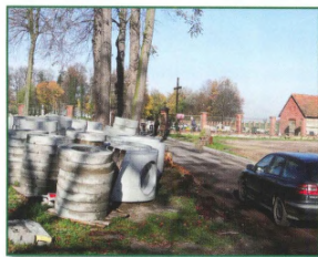
Budowa ul. Filipa Piel doprowadzi również do uporządkowania miejskiego terenu, który leży bezpośrednio przy naszym cmentarzu
