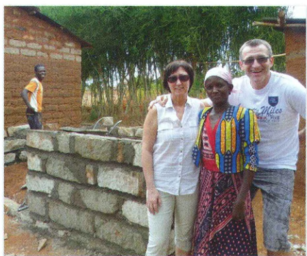
Przy budowie domu dla Moniki
